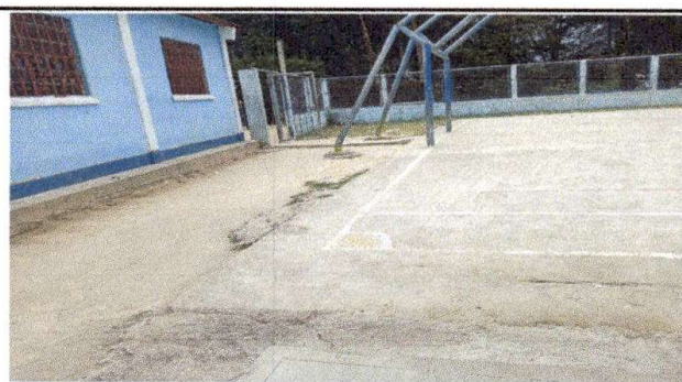
Foto 5: Reparacion de planchas de concreto de patio primera parte
