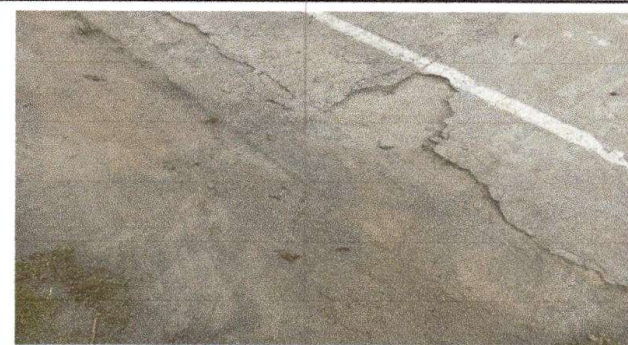
Foto 6: Reparacion de planchas de concreto de patio segunda parte
