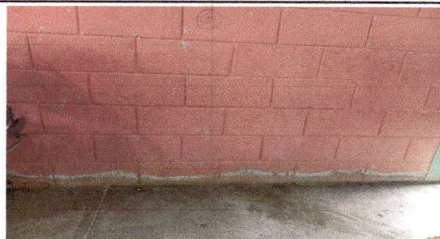
Foto 4: Pinturas de muros interiores
