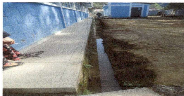
Foto 2: Reparacion de cuneta de concreto
